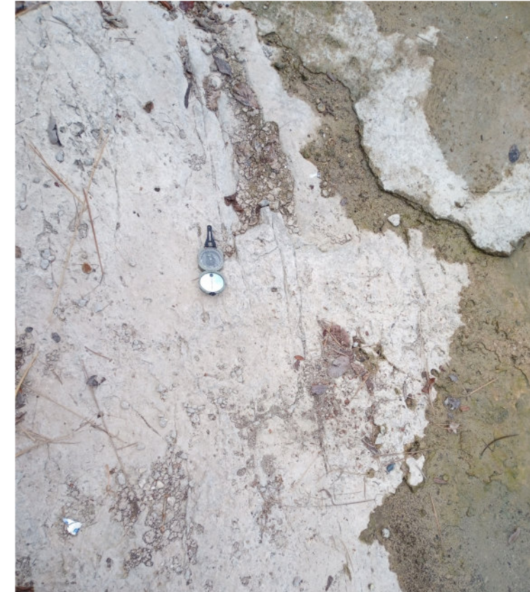
Fotografía 3. Fracturas a nivel de piso, orientadas a los lineamientos de Holbox-Tulum.
