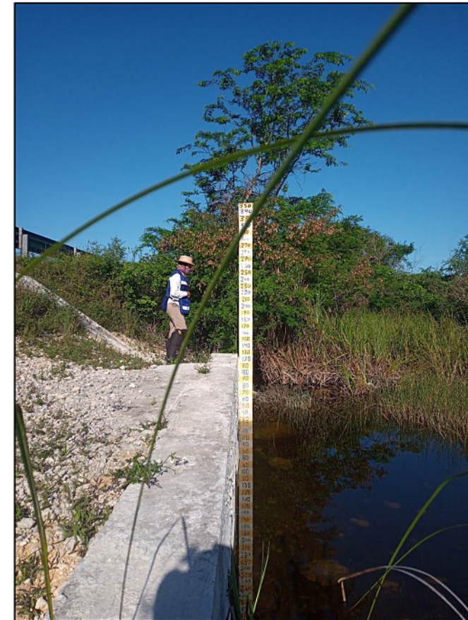
Fotografía 2. Vaguada sobre la autopista Mérida-Cancún, con escala de medición de nivel, cerca del poblado El Tinta, Yucatán.
