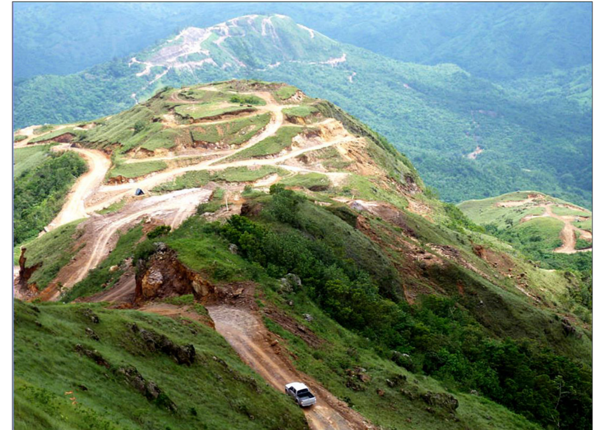
Figura.16. Cresta desmontada en el deposito de La Pava, en el extremo occidental.
