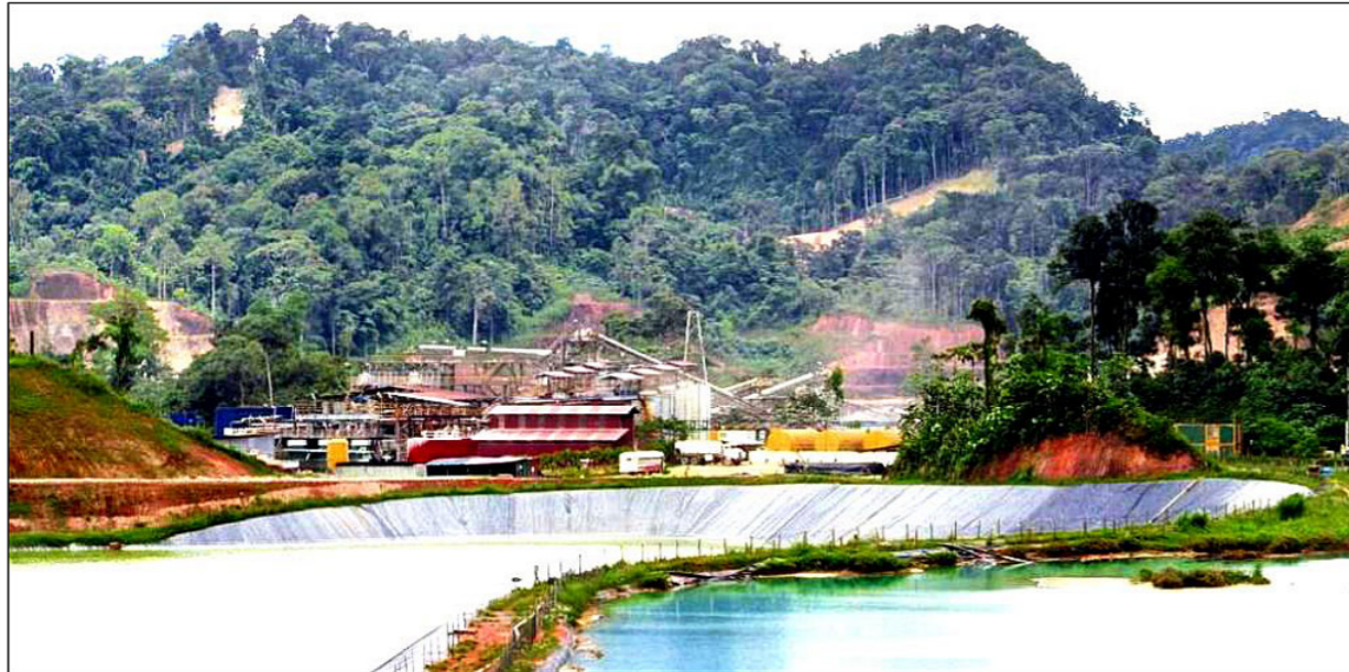
Figura.15. Instalaciones de proceso en la Mina Molejón y presa de relaves.
