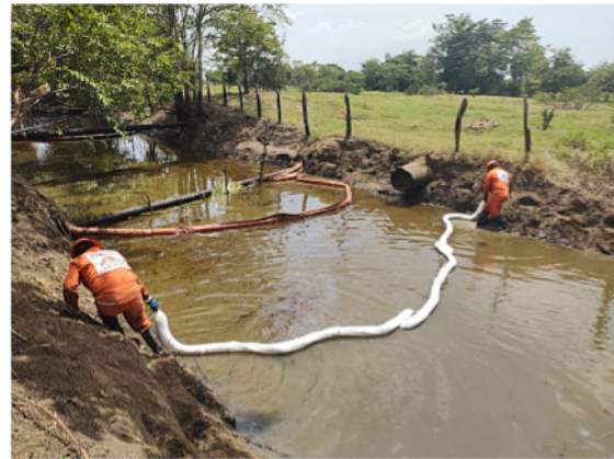
Imagen 4. Personal en el control de derrame de petróleo utilizando EPI. Colocando barrera de material absorbente artificial. Fotografía por Erick de Dios.
