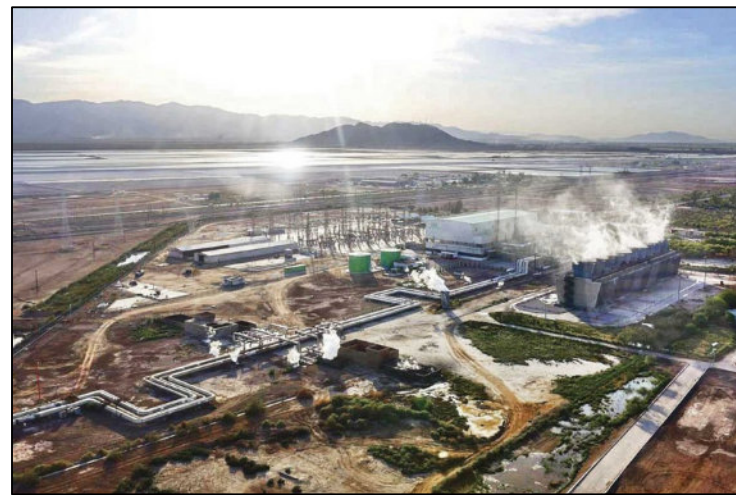
Figura 4. Planta Geotérmica de Ciclo Binario en Cerro Prieto, Mexicali (Fuente: CFE, 2021).
