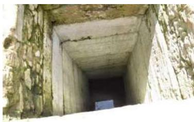
Figura 1. Jaguey de Miraca, estado Falcón, revestido de rocas para su protección. (Septiembre 2022, Estudiantes de campo DCT-USB.
