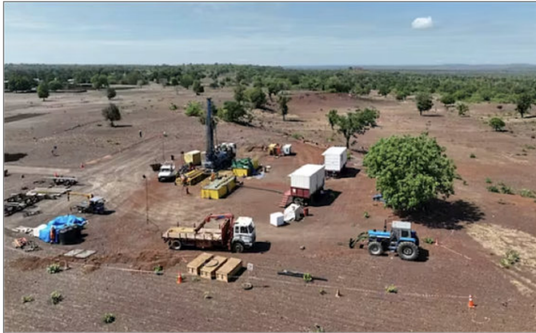
Operaciones de perforación para la exploración de hidrógeno en los alrededores de Bourakebougou (Mali). Hydroma.
