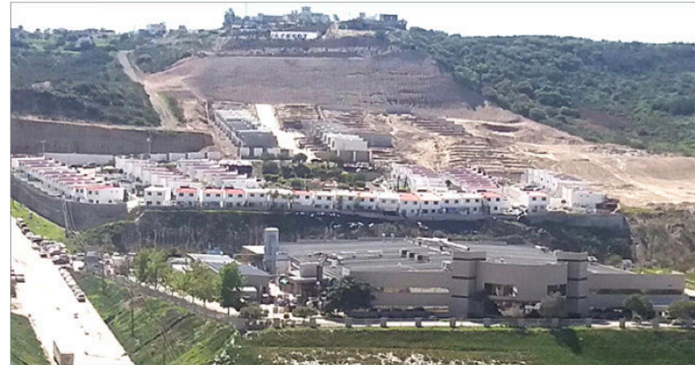
Figura 2. Panorámica del fraccionamiento Valle del Sur, Delegación San Antonio de los Buenos, Tijuana, Baja California. La fotografía tomada en febrero de 2017 desde el Libramiento Sur de la ciudad, mirando hacia el sur. En el talud norte del fraccionamiento se observa el movimiento de las primeras 12 casas del lado oeste. En primer plano está una planta maquiladora industrial BBS.
