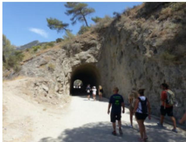
Túnel corto de acceso al Caminito del Rey, excavado en areniscas del Mioceno (Foto del autor).
