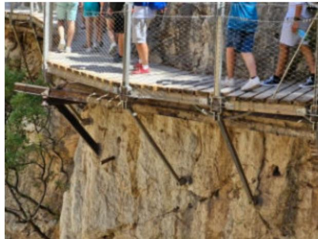
Detalle de los anclajes que soportan las pasarelas en el Caminito del Rey (Foto del autor).
