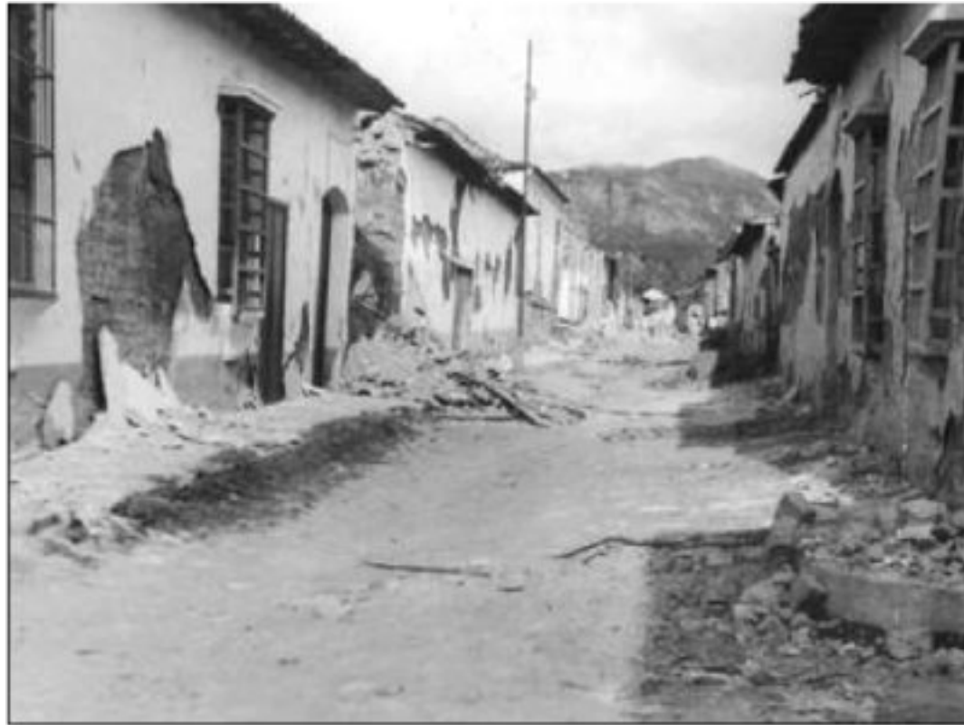
Fotografía 5 Casas destruidas en El Tocuyo, 1950. (Fuente: Archivo Audiovisual del Diario El Impulso, Barquisimeto).
