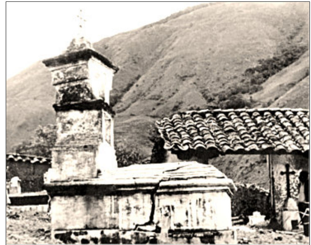
Fotografía 4. Túmulo funerario destruido en el sismo de Aricagua de 1959 y daños en la torre del cementerio Fuente: Altez y Rodríguez, 2009).
