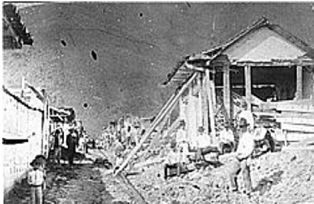
Fotografía 2. Muestra de los daños en los Andes, producto del sismo de 1894 (Fuente: G. Pilonieta, 2003).
