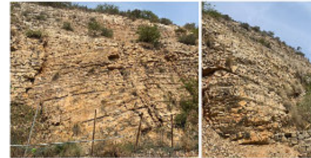
Fig. 8. Calizas masivas y fracturadas de Av. La Costa.
