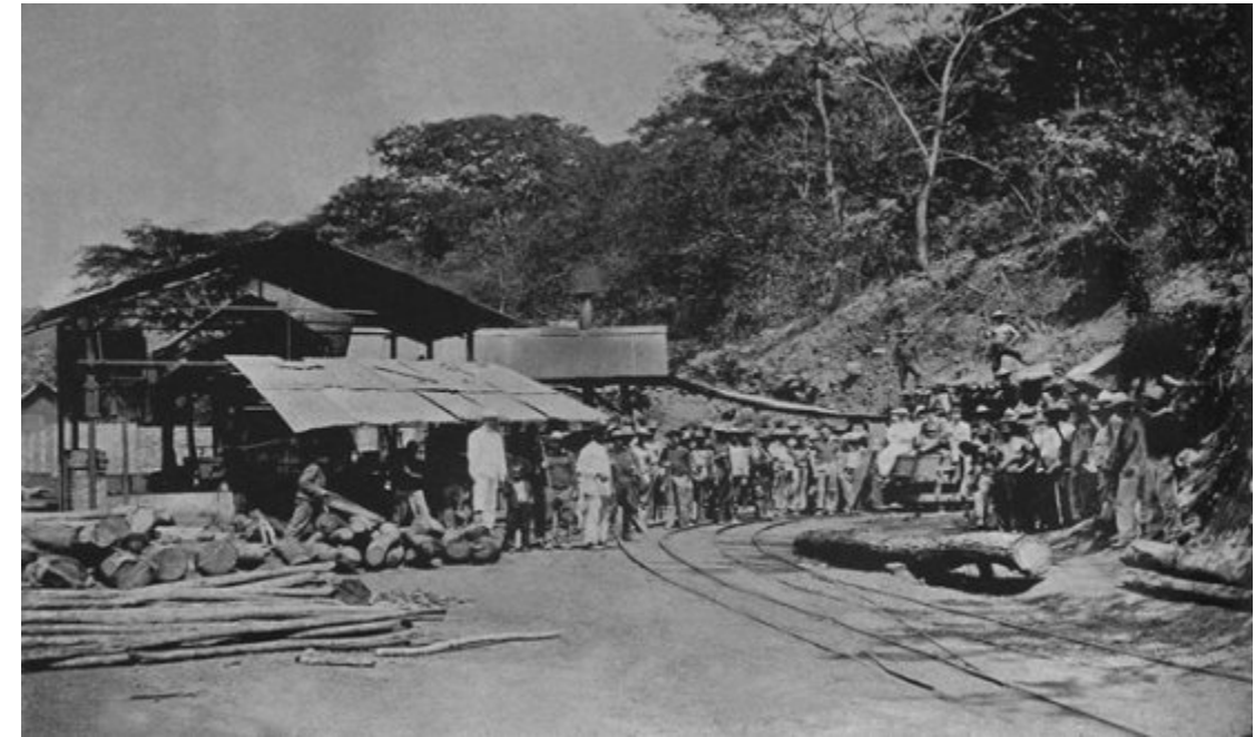
Explosión en las minas de Naricual, estado Anzoátegui, 21 de agosto de 1915 (Fuente: https://barcelonahistoriasyleyendas.blogspot.com/2012/02/fuerte-explosion-en-minas-de-naricual.html )
