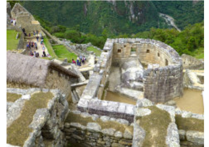
Figura 11. El Torreón o Templo del Sol, única estructura circular en todo el complejo. Fotografía del autor.
