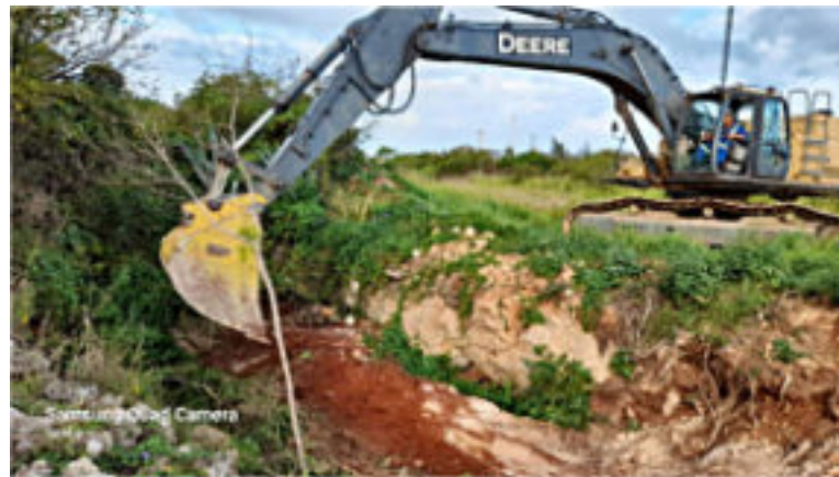
Fig. 5. Desbroce, desmonte y reexcavación de una dolina y sumidero colmatados artificialmente (Foto del autor).
