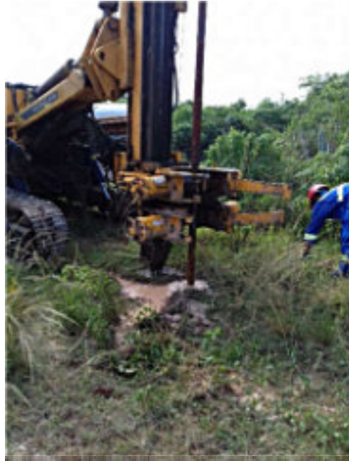
Fig. 4. Trabajos de perforación geológica (Foto del autor).
