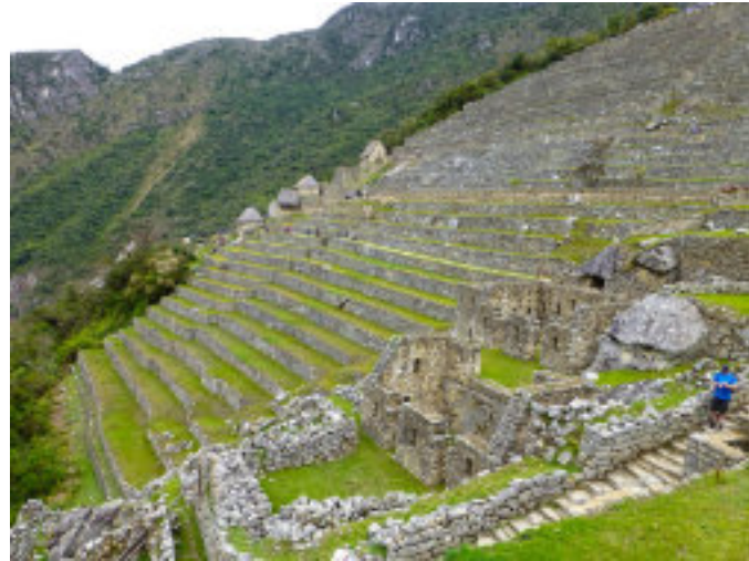
Figura 3. Conjunto de andenes cuya función principal es la protección de las laderas, y servir como terrazas agrícolas. Fotografía del autor.
