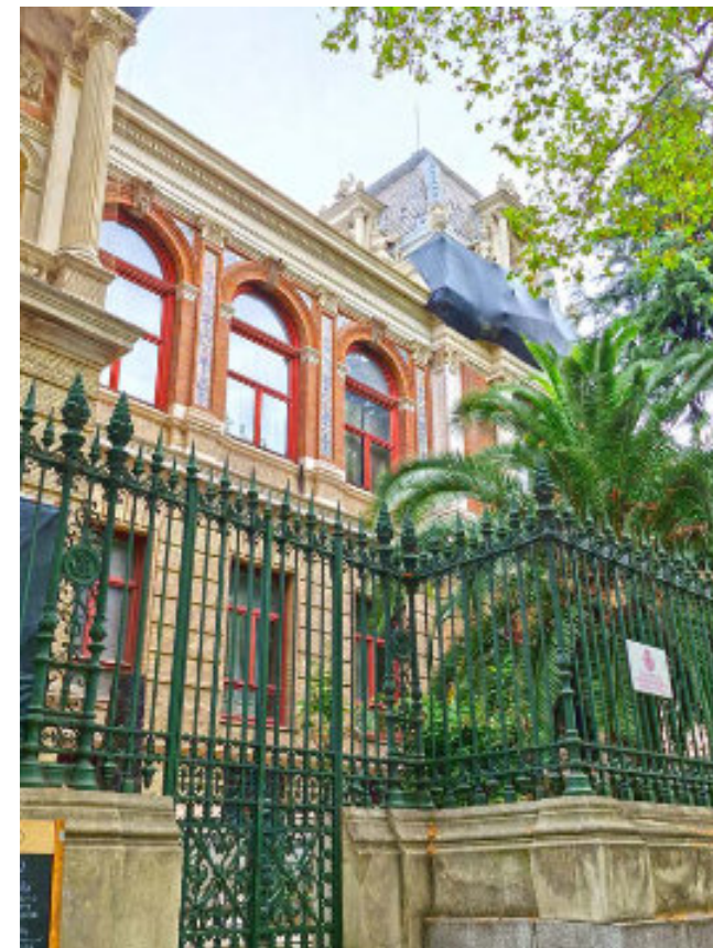
Detalle de la fachada principal derecha, vista desde la calle de Ríos Rosas. Foto del autor.
