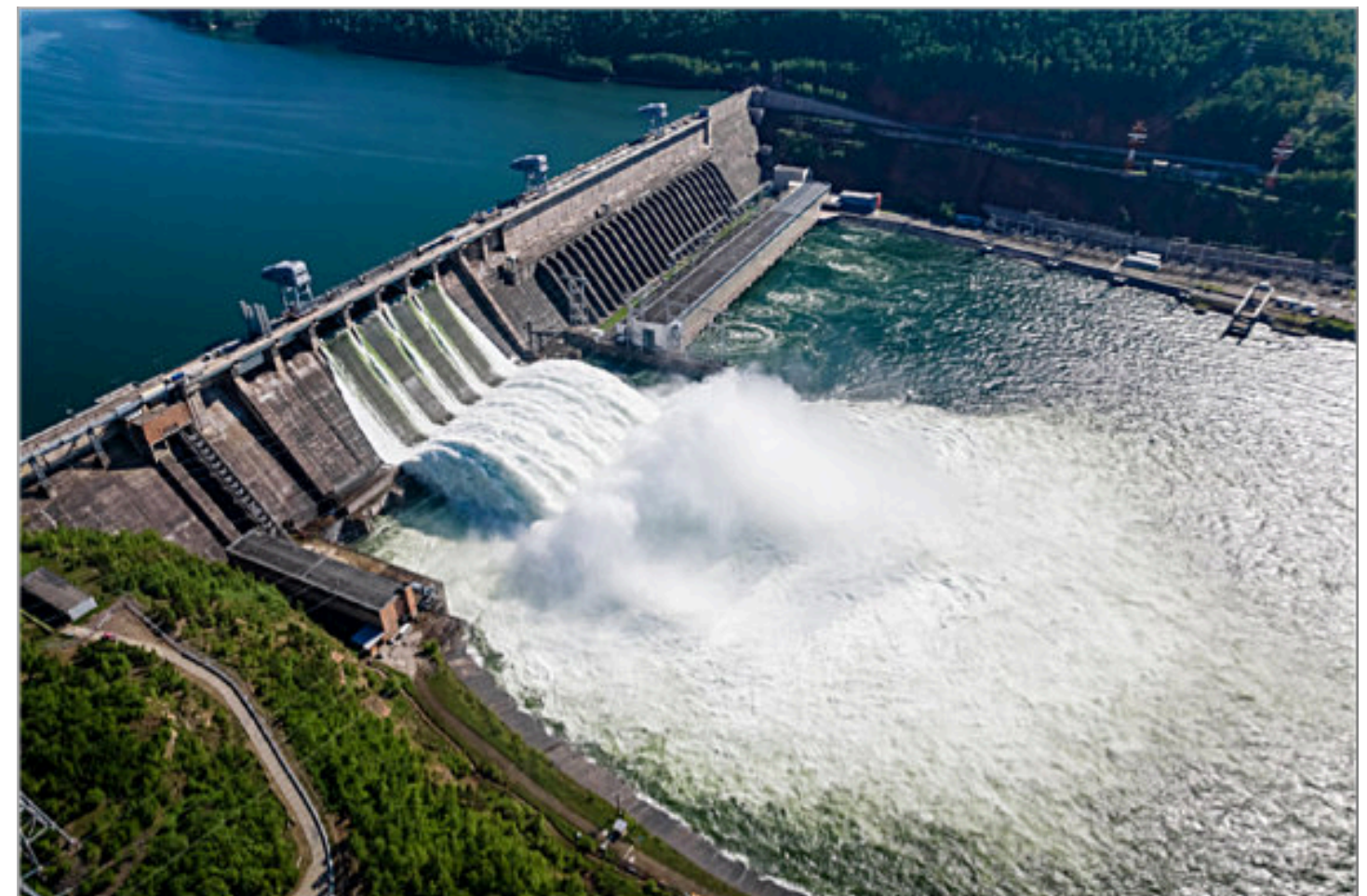
Presas generando energía hidroeléctrica.
