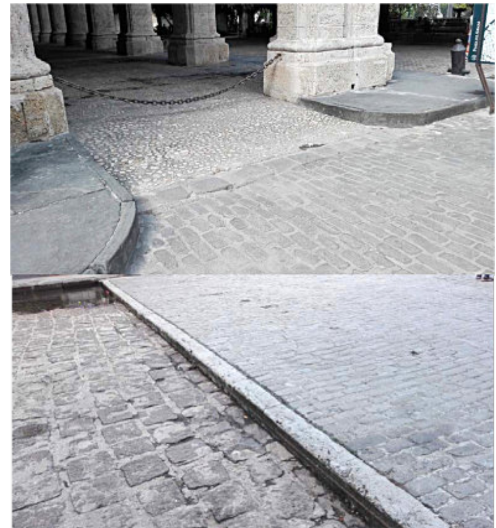
Figura 4. Aceras con pizarras gris oscuras, contenes con piezas grandes y medianas, así como adoquines grandes y pequeños, todos de granitos de Cape Ann. La entrada de coches está empedrada con cantos rodados. Esquina de Obispo del Palacio del Segundo Cabo. Plaza de Armas.
