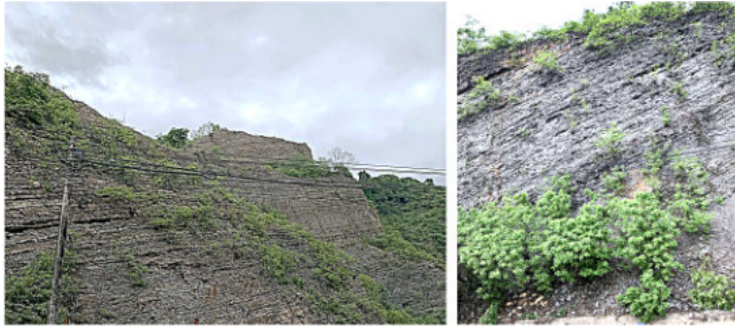
Figura 3. Afloramiento de rocas volcano-clásticas de la Formación Cayo, Vía Perimetral (Foto: J. Porras).
