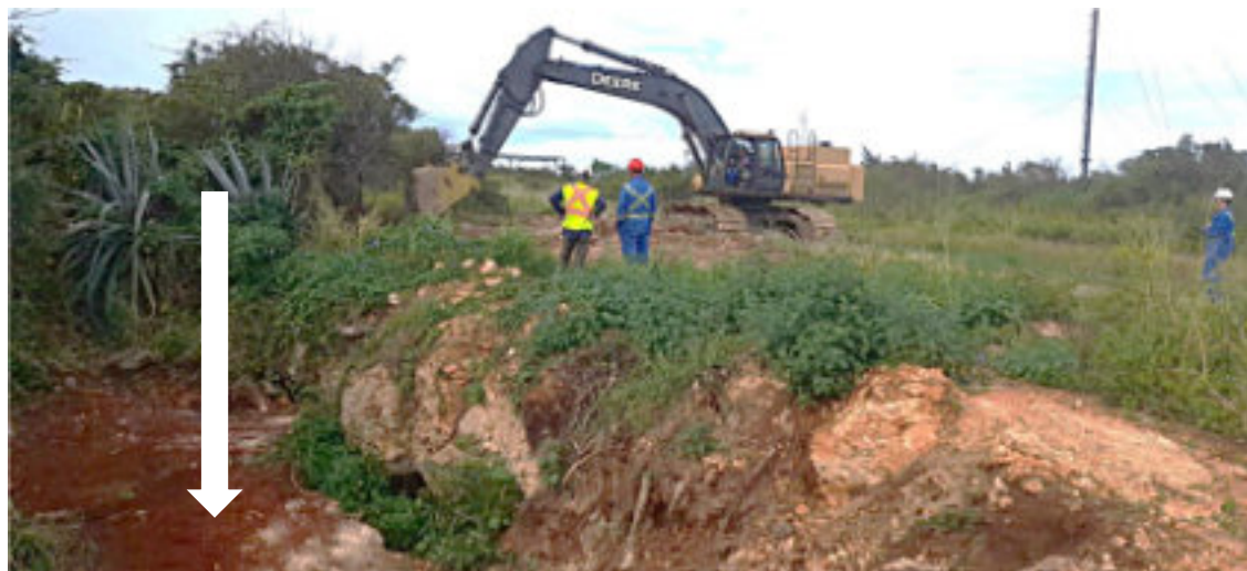
Fig. 2. Corrección de la estabilidad en una dolina subsidente (Foto del coautor Molerio-León)
