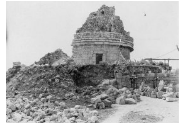
El Caracol mostrando su sección este (izquierda) totalmente derrumbada, mientras la sección derecha ya muestra los resultados de la restauración emprendida por Morley en 1929. Fuente:
