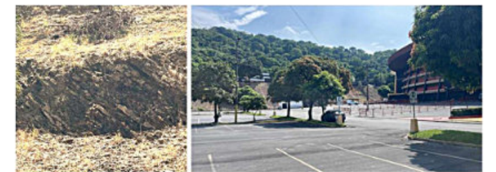
Figura 9. Entorno geológico del Estadio Monumental Isidro Romero Carbo (Guayaquil, Ecuador). Se observan taludes y laderas asociadas a las colinas de la cordillera Chongón-Colonche, conformadas por rocas sedimentarias (calizas, areniscas y lutitas) de la Formación San Eduardo.
