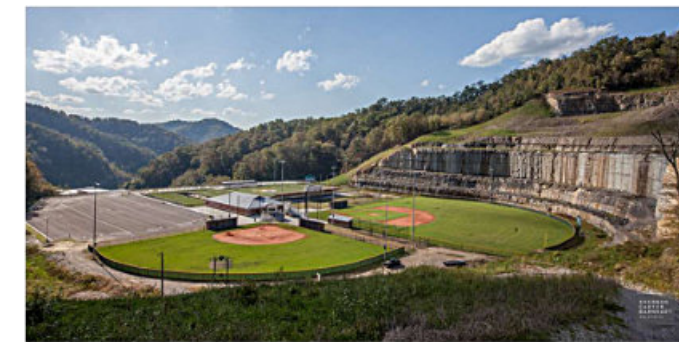
Figura 8. Campo deportivo construido sobre una antigua mina a cielo abierto (strip mine) en el este de Kentucky (EE. UU.). El estadio de la Floyd Central High School se emplaza en un paisaje donde los taludes escalonados de areniscas y lutitas reflejan la actividad extractiva previa.
